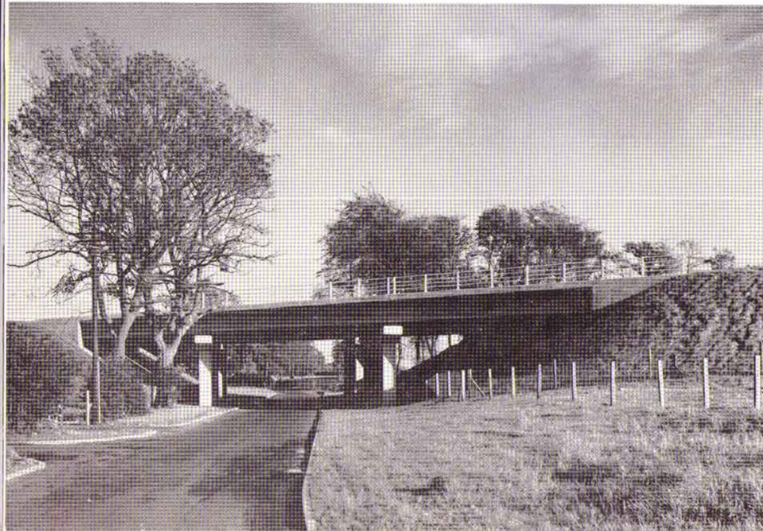
PLATE 10. D'URTON LANE BRIDGE.
